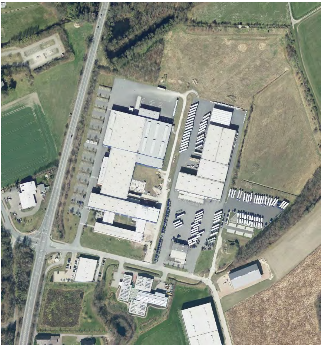
Abb. 5 Hörmann KG Antriebstechnik, Michaelisstraße, Brockhagen
